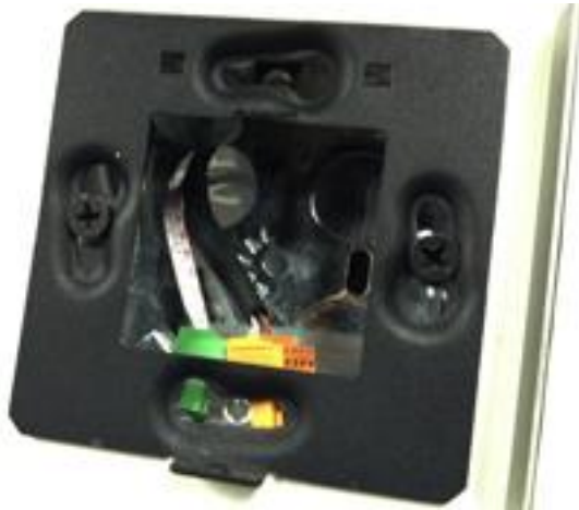
الشكل رقم 2: الحامل الحديدي الخاص باللوحة الرقمية المتغيرة، يتم تزويده مع العلبة، و يثبت بعلب الحائط 55
