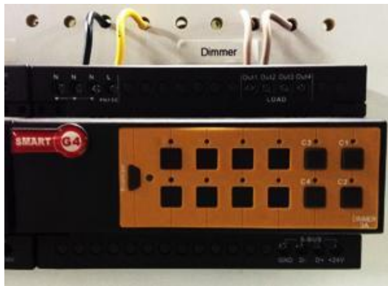
תמונה 16-חיבור 2 מעגלי מאור לבקר 4 ערוצים
