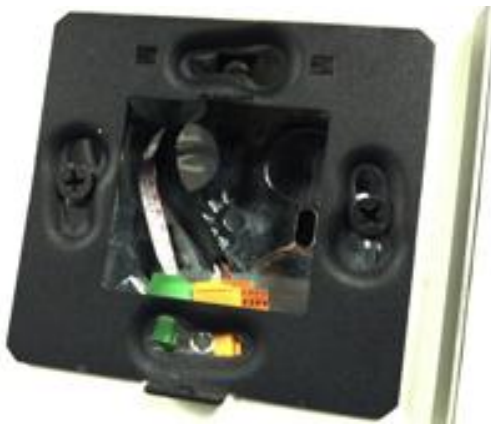
תמונה 2-טבעת ברזל לחיבור פנל צג לקופסא 55
